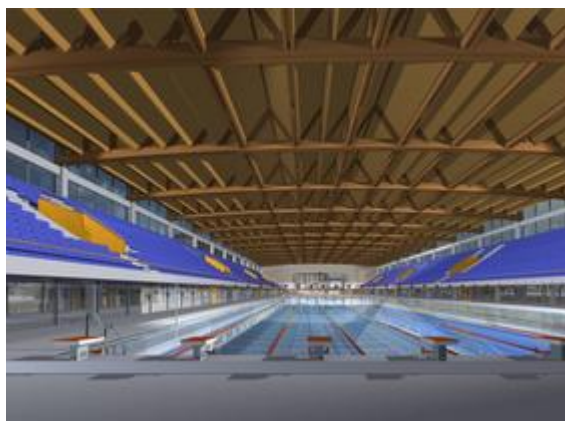
Fot.: Alstal Budownictwo
